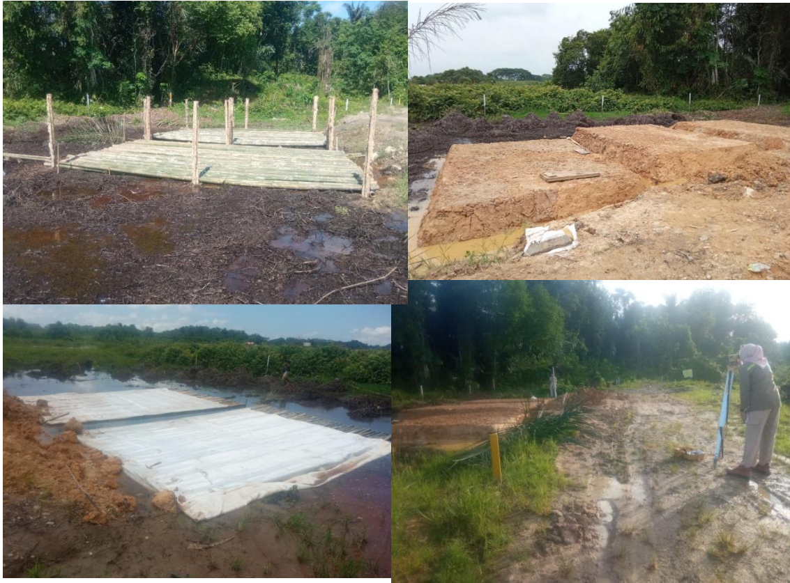
Gambar 6. Pembuatan Pile Raft dan Timbunan Pertama.
