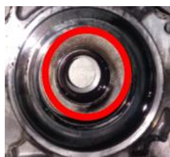
Gambar 5. Bagian pompa bahan bakar yang rusak.
