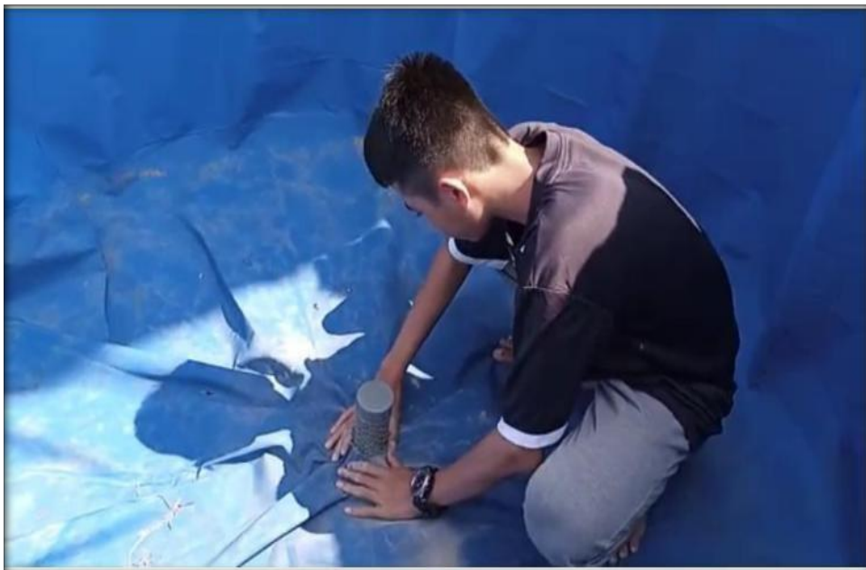
Gambar 4. Pemasangan Pipa Pembuangan Kolam Bundar oleh Siswa.
