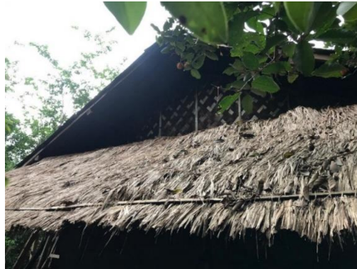
Bagian Atap Rumah Adat Jalawastu Yang Masih Menggunakan Rumbia Sumber : Dokumentasi Peneliti, Maret 2024
