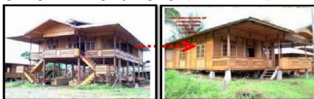
Gambar 2 Rumah panggung Minahasa yang mengalami perubahan konstruksi
