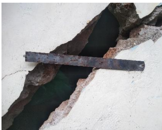
Gambar 11. Tenger pada Retakan Dinding
